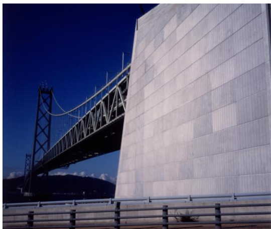
「明石海峡大橋」
